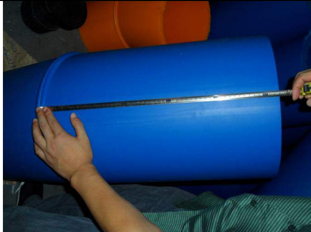
Length check of PE fitting
